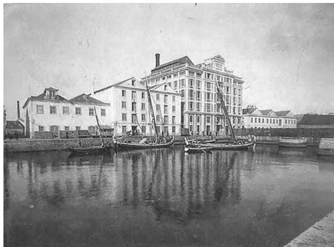
Fig. 9. José Maria da Silva, Fábrica de Moagem de Cara- mujo . Bâtiment terminé, 1898 (Fonds Bétons Armés Hennebi- que, BAH, Ifa n° 076)
