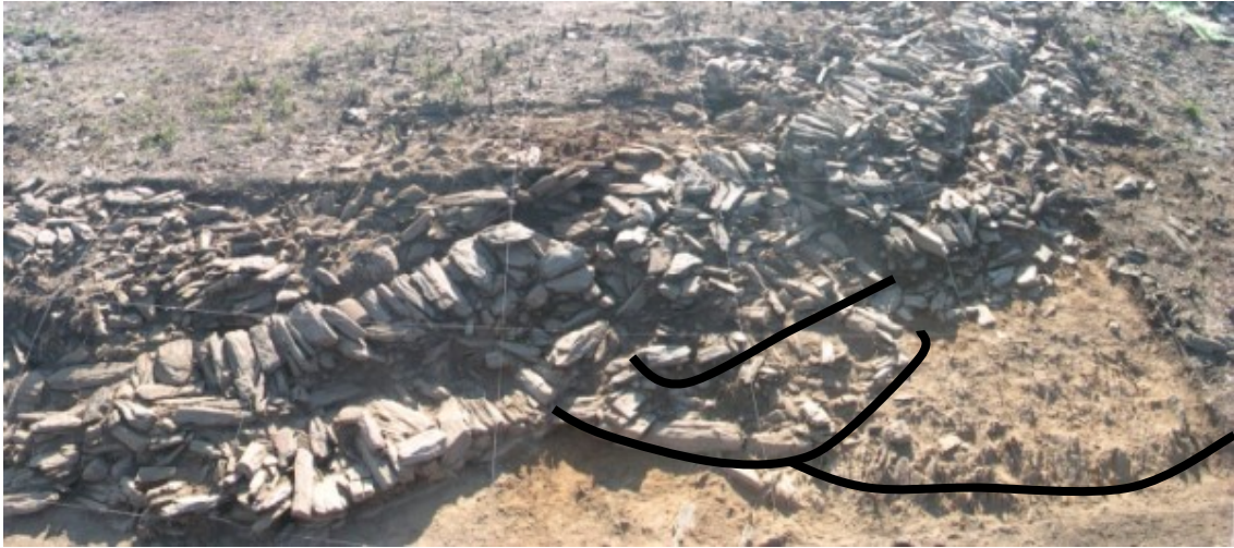
Figura 222 – Aspecto geral da passagem 4. As linhas assinalam os prováveis patamares de acesso à passagem (foto de João Muralha).
