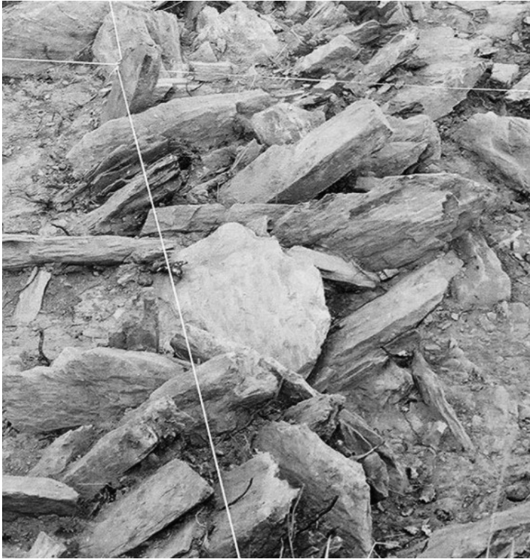
Figura 199 – Exterior do “bastião” B. Pormenor da colocação de lajes de xisto pertencentes ao sistema de contrafortagem (Foto de João Muralha).
