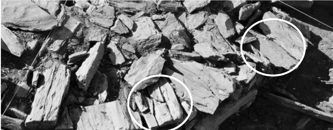
Figura 195 – Pormenor do estalamento de lajes do bastião B (Foto de João Muralha).
