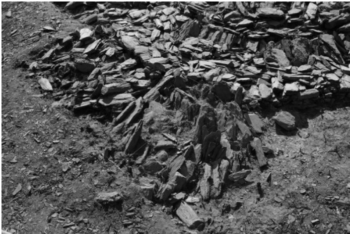
Figura 95 – Pormenor do sistema de contrafortes a Norte da estrutura “Torre”.
