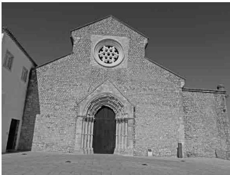
Fig. 1 Santarém. Igreja de São Francisco. Vista atual da fachada principal.
