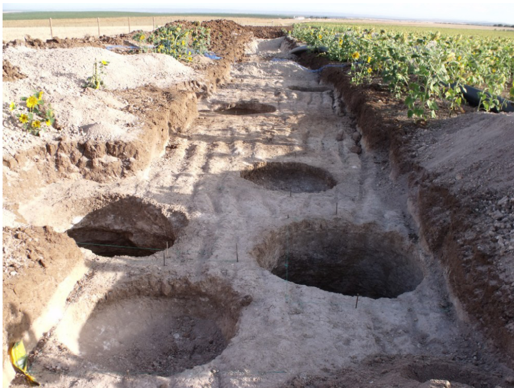
Figura 3 – Vista geral da área intervencionada.
