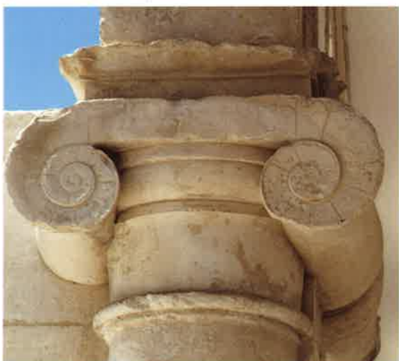
5 Colégio das Artes, capitel jónico da galeria do "lanço novo".
