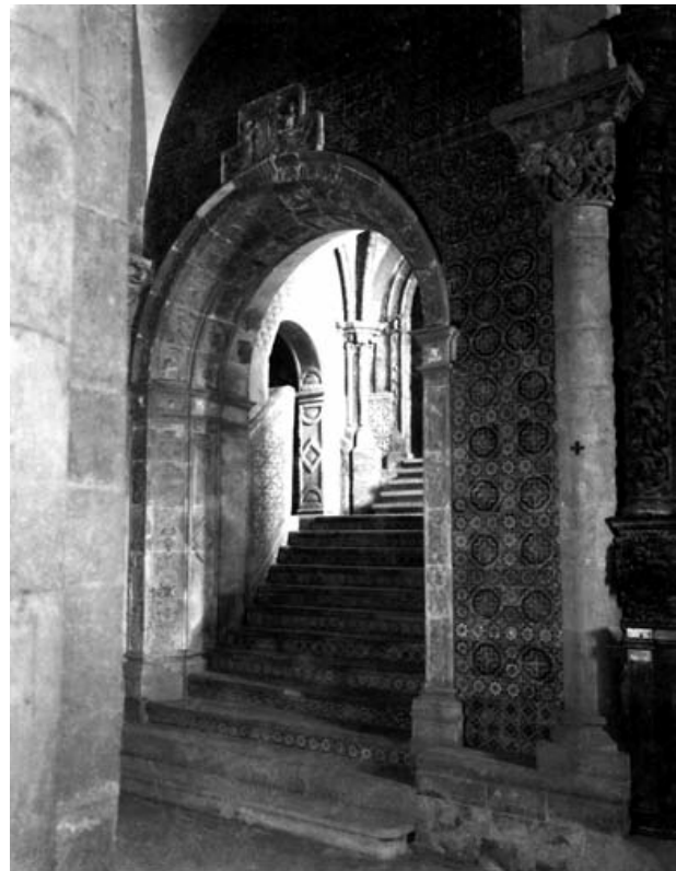
Antiga ligação ao claustro. Em segundo plano são visíveis os arcos de D. Afonso Castelo Branco e D. Jorge de Almeida, no acesso imediato ao claustro: IHRU, 095632.
