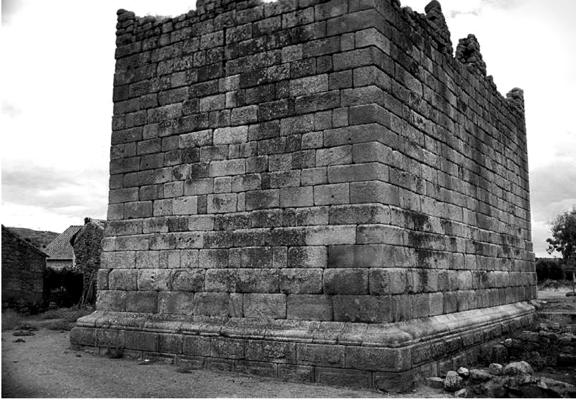
Fig. 5. Podium do templo romano de Idanha-a-Velha sob a torre do castelo templário.
