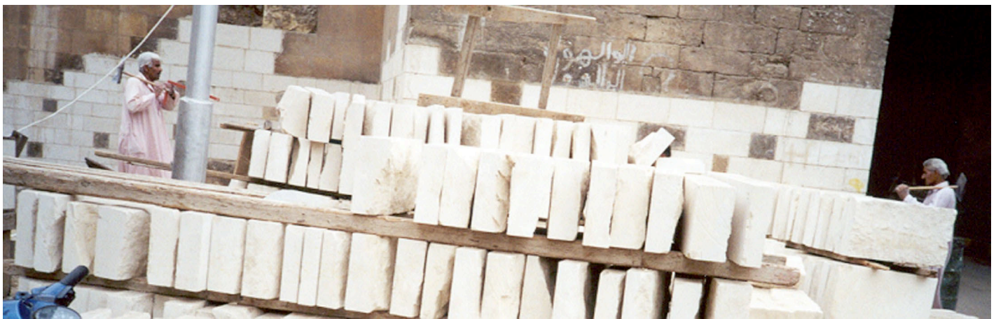
Figura 3. Desbaste final da pedra feito de forma tradicional na recuperação de um monumento no Cairo, Egito. Fotografia do autor, 2007.
