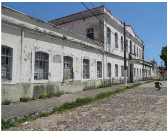
Figura 8 – Rua Cel. Lins Caldas em frente a Casa dos Estudantes com pavimentação quase que completa em blocos de arenitos ferruginosos (blocos em marrom escuro). Fonte: autores.
