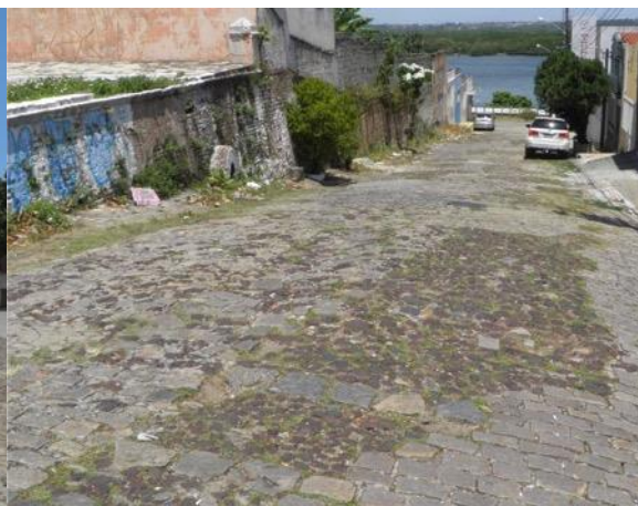
Figura 9 – Rua Quintino Bocaiúva com resquício da pavimentação original formada por blocos de arenitos ferruginosos (em marrom escuro) justapostos a blocos de granitos (em cinza). Fonte: autores.
