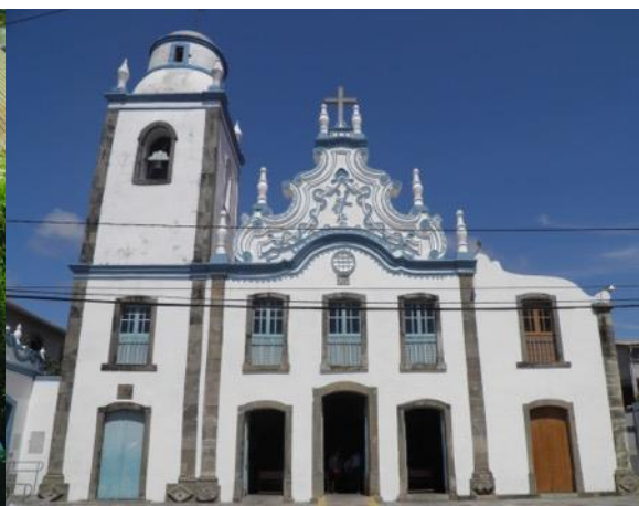
Figura 5 – Visão frontal da Igreja de Santo Antônio (conhecida também por Igreja do Galo), com suas pilastras formadas por arenitos calcíferos. Fonte: autores.
