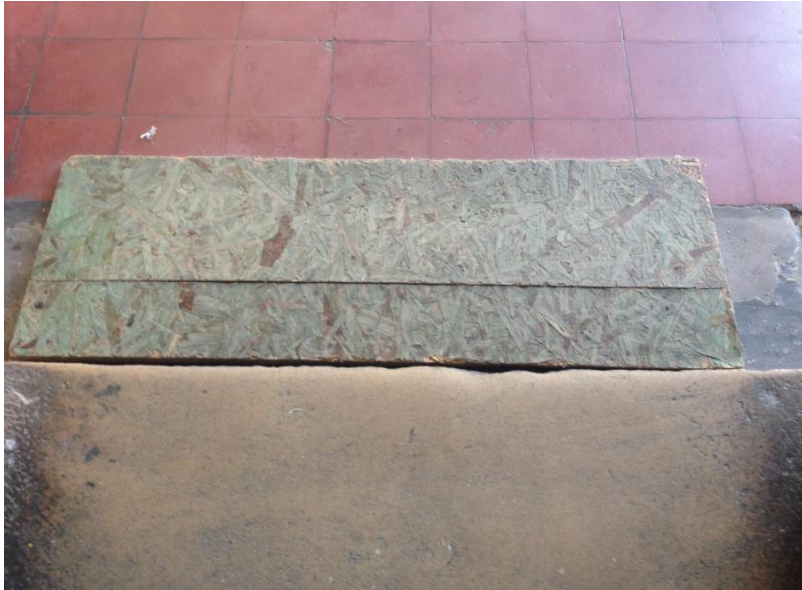
Figura 11 - Igreja de São Francisco. Soleira (parte inferior da imagem) e rampa em OSB entre a portaria e o claustro.
