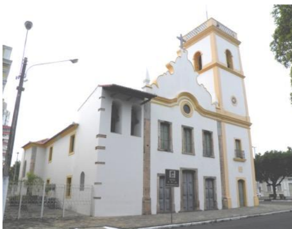
Figura 6 – Igreja de Nossa Senhora da Apresentação com suas pilastras e cercaduras das janelas feitas com arenitos calcíferos. Fonte: autores.
