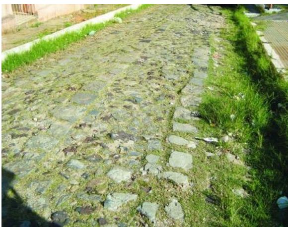
Figura 4 – Rua Voluntários da Pátria com sobreposição de rochas – granitos (em cinza) e arenitos ferruginosos (em marrom) – estas últimas remanescentes das primeiras pavimentações. Fonte: autores.
