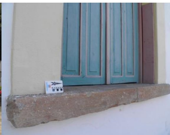
Figura 13 – Soleira em arenito calcífero encontrada na antiga sede do IPHAN/RN. Fonte: autores.
