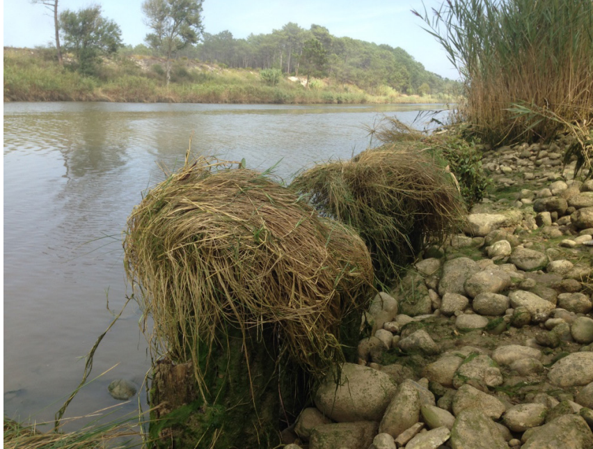
Vestígios das fundações do Dique de Reinaldo Oudinot, Arquivo Pessoal, Leiria, 2016.
