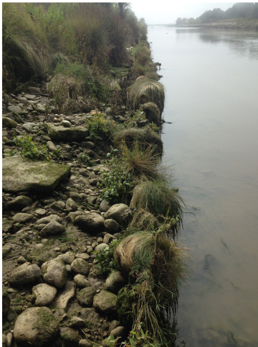
Vestígios das fundações do Dique de Reinaldo Oudinot, Arquivo Pessoal, Leiria, 2016.
