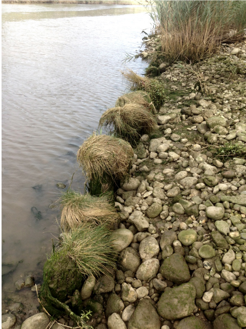
Fig.13 Vestígios das fundações do Dique na foz do rio Lis, Arquivo Pessoal, Leiria, 2016.
