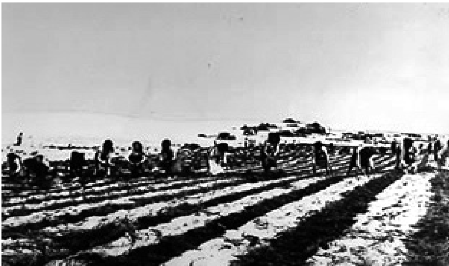
Fig.34 “Abertura de regos”; MENDIA, Henrique de, Estudo sobre a Fixação e Aproveitamento d’uma parte das Areias Moveis das Costas de Portugal , Lisboa, Typographia Universal, 1881.
