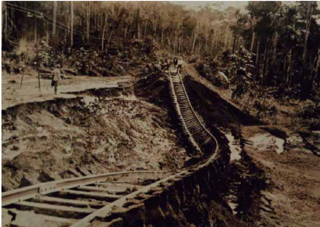
Figura 05. Construção da estrada de ferro Madeira Mamoré; Declive perto de Santo Antônio. Merrill.1910 Fonte: Coleção Pyles, Neeleman, 2011, p. 151.
