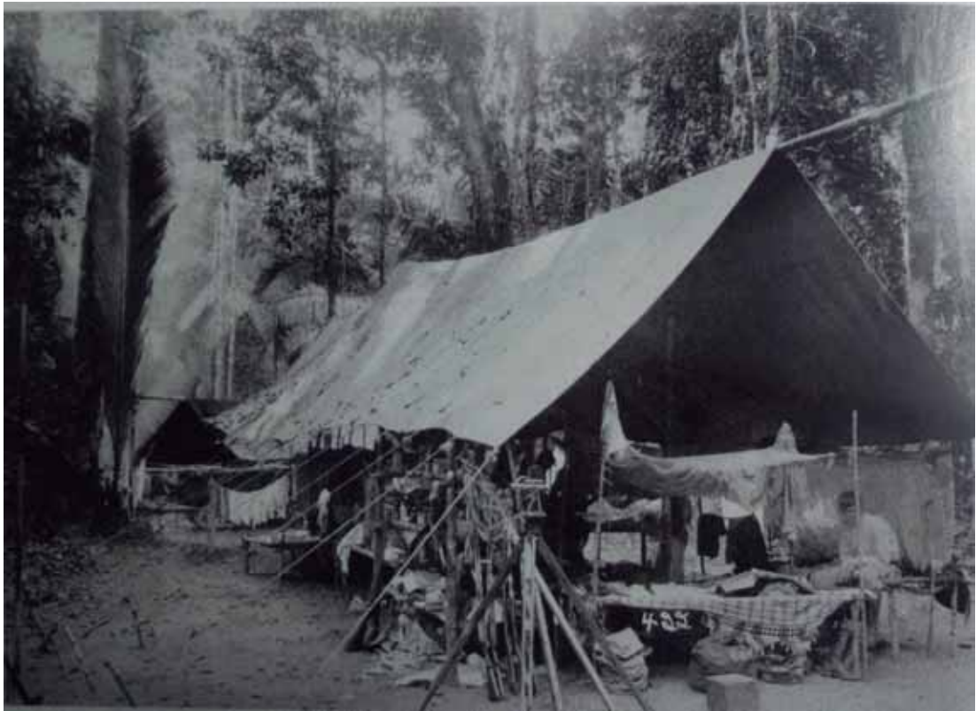
Figura 131. Acampamento e rede. Merrill (construção da estrada de ferro madeira Mamoré).
