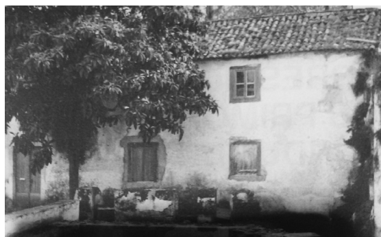
Img. 166 - Moinho de Santa Bárbara (demolido).
