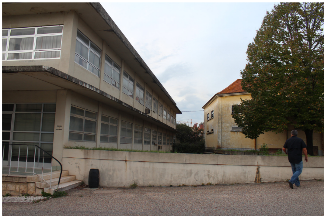
Img. 118 - Fotografia atual.
