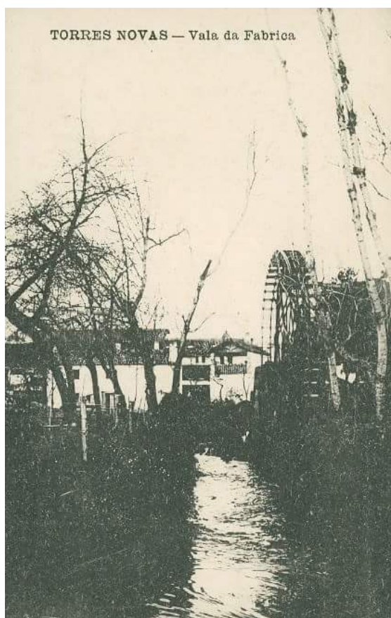
Img. 165 - Vale da fábrica (aterrada).
