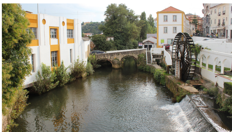
Img. 7 - Tarambola e açude no centro da cidade.
