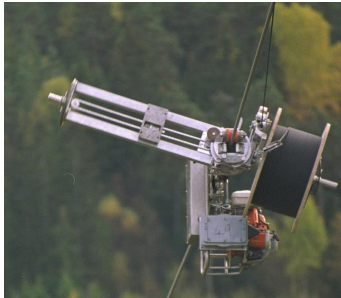
Figura iii - Operação de instalação de cabo de fibras ópticas tipo WRAP em torno de cabo OPGW existente [6].
