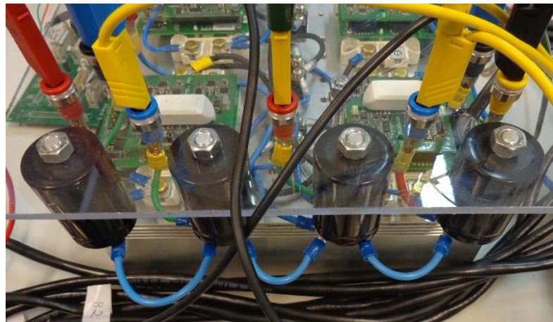
Figura B.10 – Montagem dos condensadores no protótipo.
