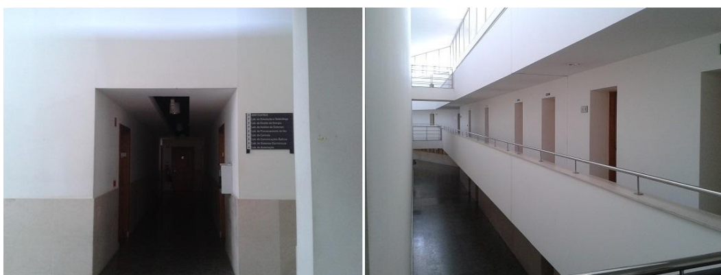
Figura 35: Corredor de acesso ao LGE e corredor dos Gabinetes do Piso 3.
