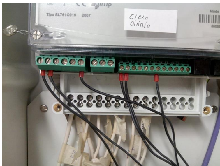
Figura 36 - Bornes de ligação utilizados no contador ACTARIS SL7000.
