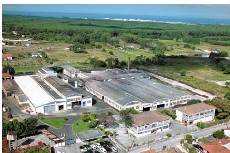
Figura 1.1 - Instalações da Böllinghaus Steel na Vieira de Leira.
