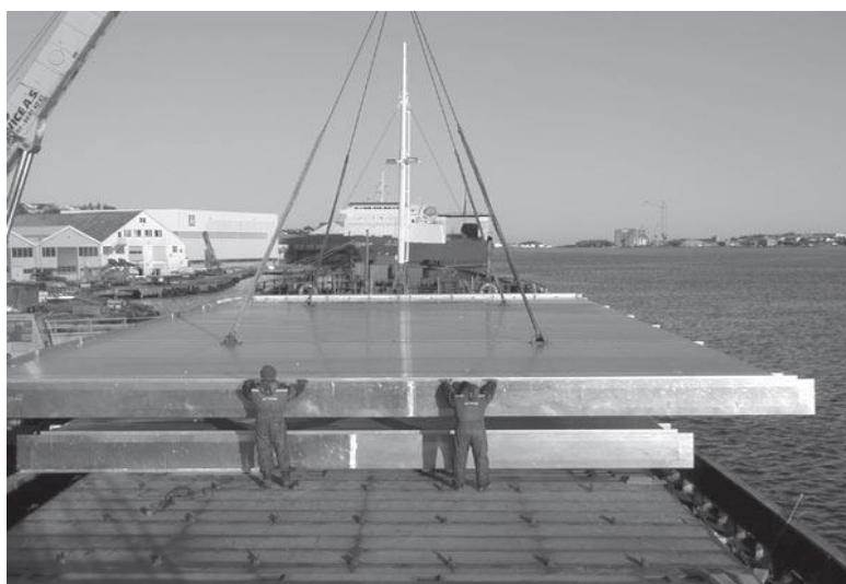
Figura 2.6 Pré-fabricados em alumínio utilizados em plataformas petrolíferas [11]
