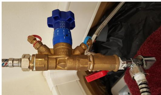
**Figura 2.4:** Válvula de Regulação de Caudal
