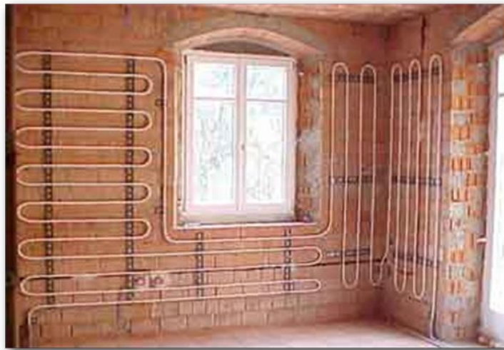
Figura 2.3. Sistema de paredes radiantes em construção.
