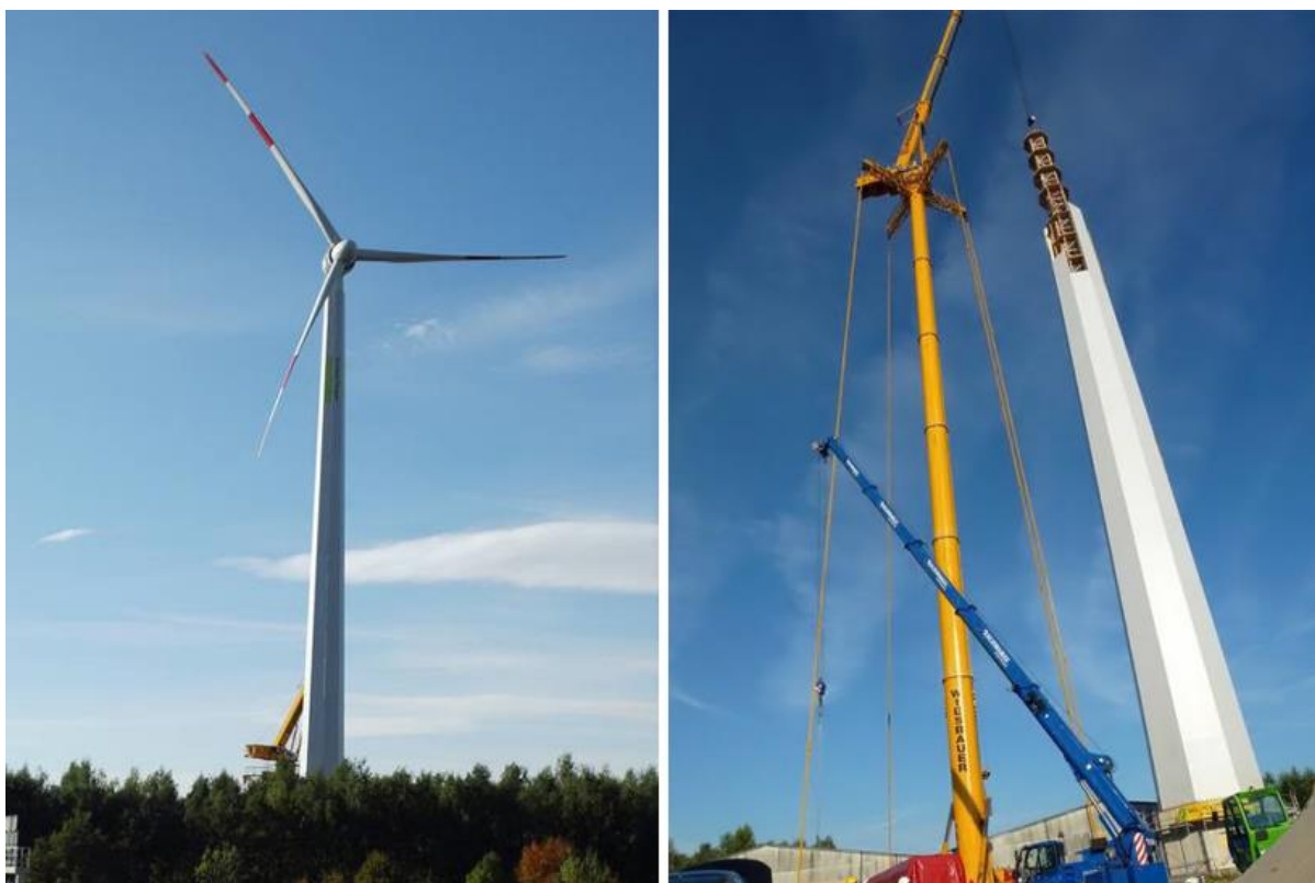
Figura 2.6 – Torres eólicas em CLT – Timber Tower (designboom, 2014)
