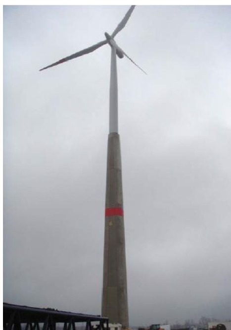
Figura 2.4 – Torres híbridas aço/betão (Engström et al, 2010)
