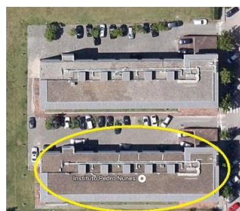
Figura 3.2 - Vista superior do edifício B (obtido em janeiro de 2015, a partir de maps.google.pt)
