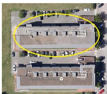
Figura 3.1 - Vista superior do edifício A (obtido em janeiro de 2015, a partir de maps.google.pt)
