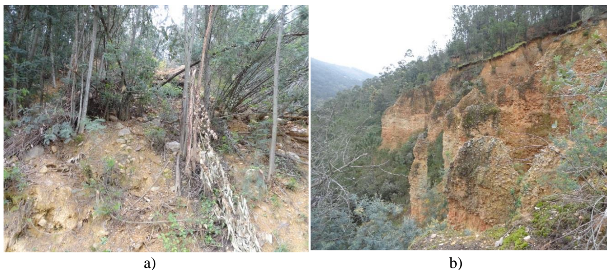
Figura 4.6 – Locais de instabilização na área de estudo: a) deslizamento do talude na margem direita do rio do Sotão, b) ravinamento profundo, com cerca de 80 m de altura na margem esquerda do rio Sotão.
