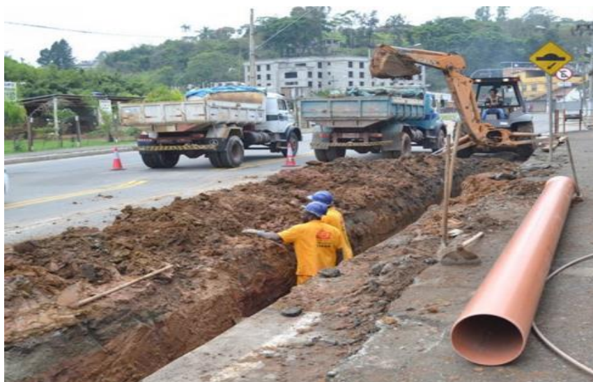
Figura 2.5 - Parte da construção de uma rede de esgotos em meio urbano (Fonte: CESAMA@2015).
