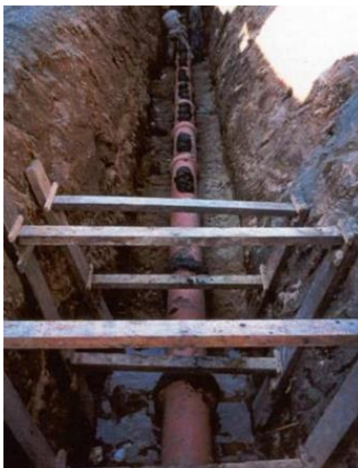
Figura 3.16 - Entivação de uma vala (Adaptado de SNSA, 2008).
