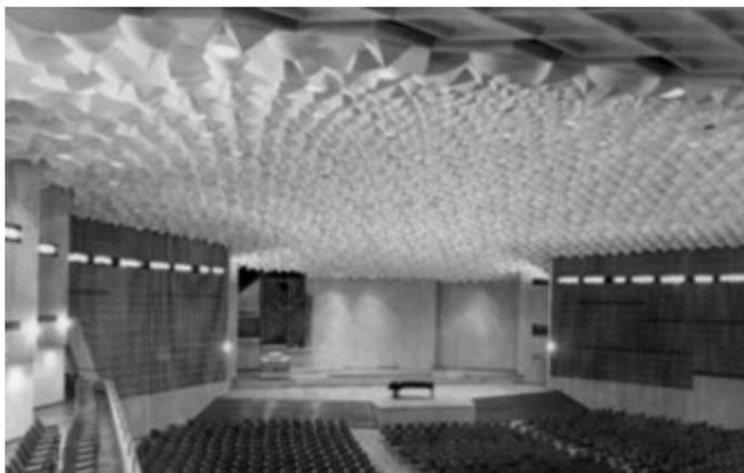
Figura 3.7– Representação de pirâmides refletoras inseridas no teto do palco Beethoven, Bonn, Alemanha
