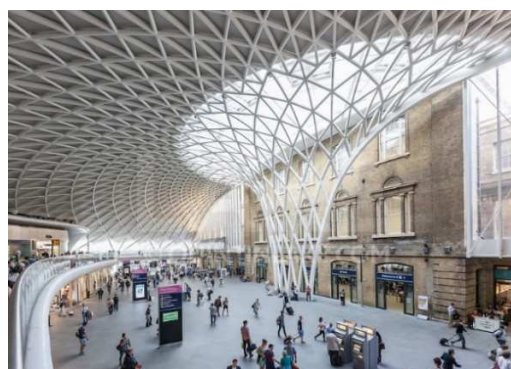
b) Cobertura na Estação de King's Cross, Londres (Quintin Lake@, 2015)
