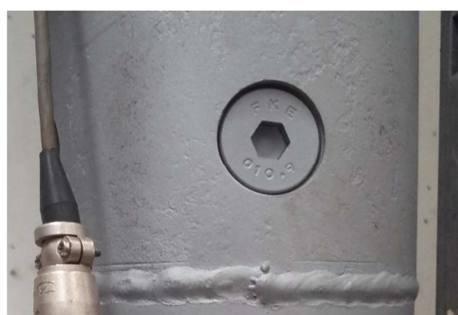
Figura 1.4 – Pormenor do parafuso da ligação (Vasconcelos, 2015)
