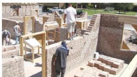
Figura 2. 8 - Construção em BTC (Duarte, 2013).
