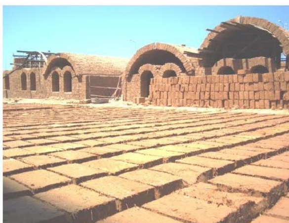
Figura 2. 6 - Fabrico de Adobe em Sheik Zayed, Faixa de Gaza (aventar@).
