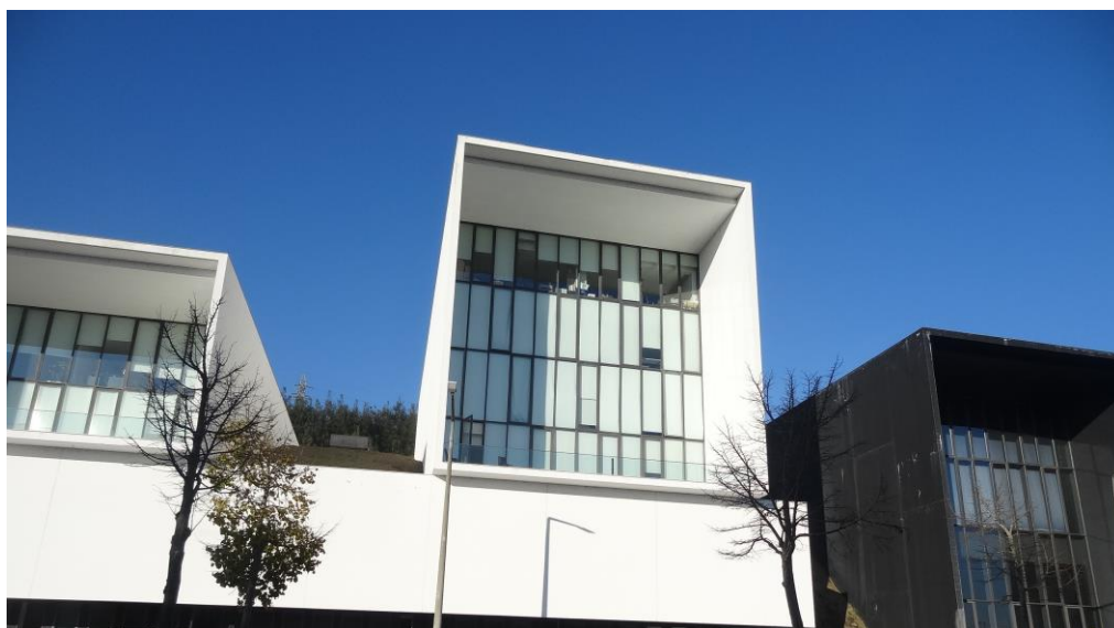
Figura 3.4 – Envidraçados das fachadas voltadas a Sul, Bloco Central, FCTUC
