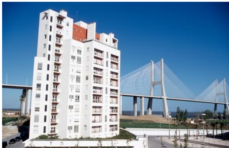
Figura 3.12 – Edifício Torre Verde, Parque das Nações, Lisboa (de http://www.lidera.info/ )
