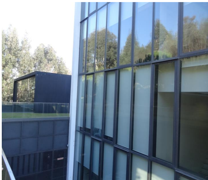
Figura 3.3 – Envidraçados das fachadas voltadas a Norte, Bloco Central, FCTUC
