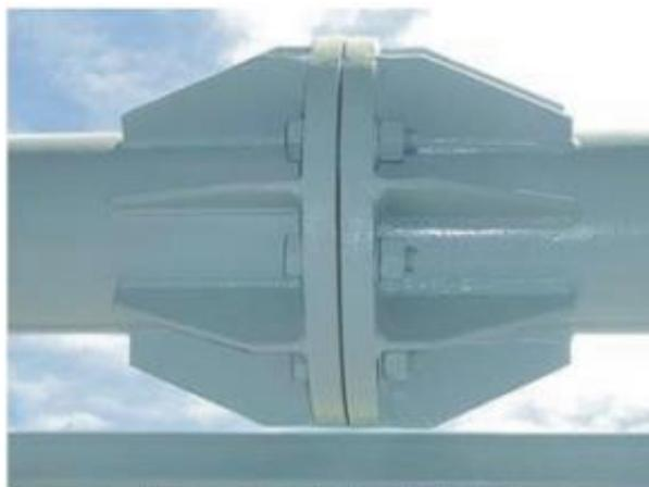
Figura 1.4 - Ligação de Emenda Aparafusada Tradicional (fec.unicamp@, 2015)
