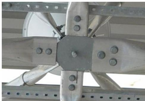
Figura 2.9 - Ligação com Terminais Achatados Aparafusados e Chapa de Gusset (Technica, 2010)
