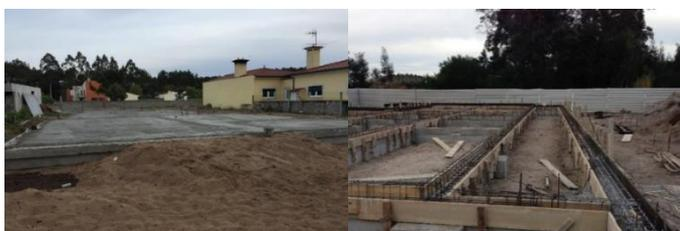
Figura 2.1 – (a) Ensoleiramento geral e (b) Sapata contínua.
