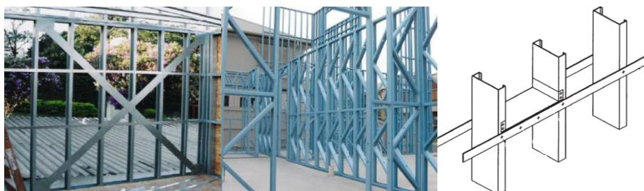
**Figura 2.4 – Elementos adicionais: (a) fitas metálicas em cruz, (b) perfis metálicos em U dispostos em K, (c) perfis metálicos em U e (d) fitas metálicas (Adaptado de [17], de [18] e de [13], respetivamente).**
