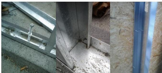
Figura 2.11 – Ligação (a) fundação-guia, (b) guia-montante, (c) montante-revestimento.
