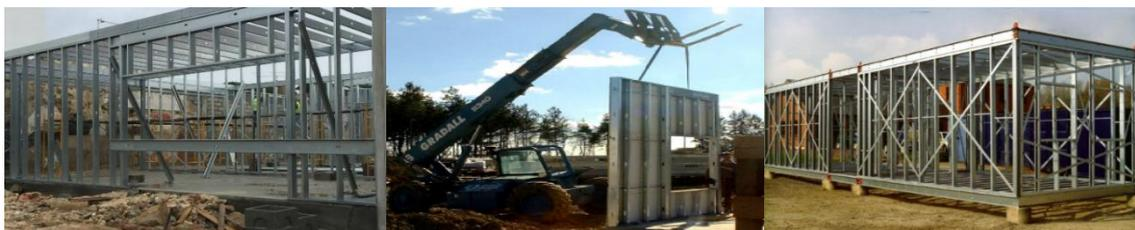
Figura 2.2 – Construção (a) *Stick-built*, (b) por painéis e (c) modular (Adaptado de [4]).
