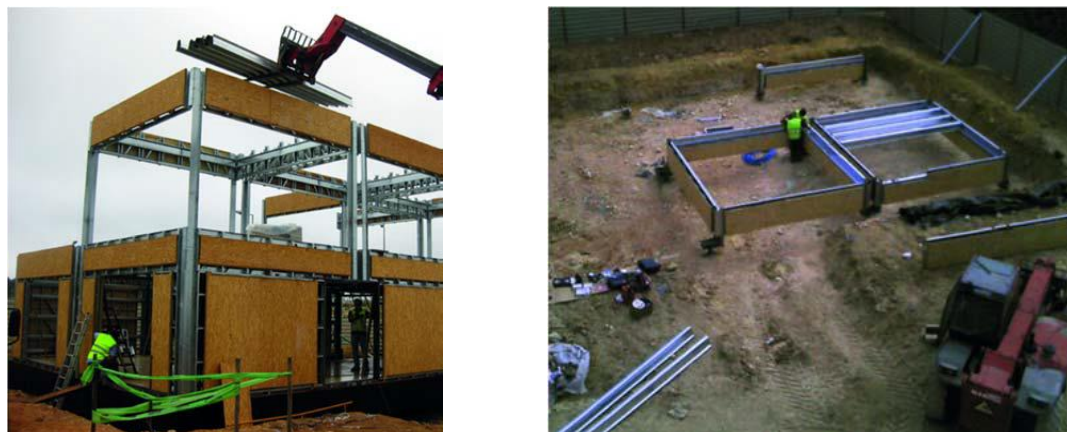
Figura 1.1 – Moradia construída em “ Lightweight Steel Framing ” pela empresa Cool Haven.
