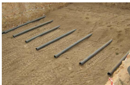
Figura 4.2 – Instalação das tubagens do SVG no solo
