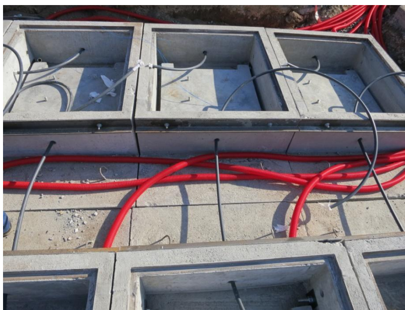
Figura 3.22 – Tratamento da tubagem para o sistema de geração de energia
