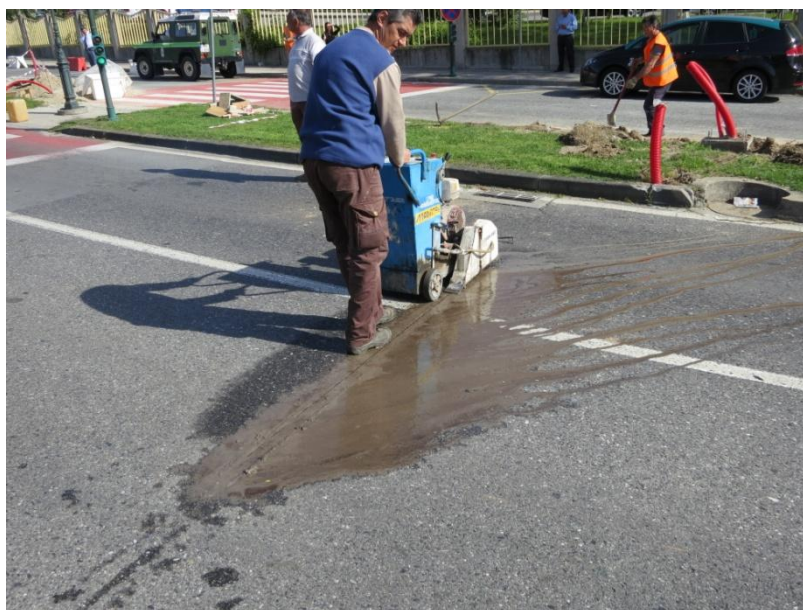
Figura 3.18 – Utilização de uma serra durante o corte do pavimento
