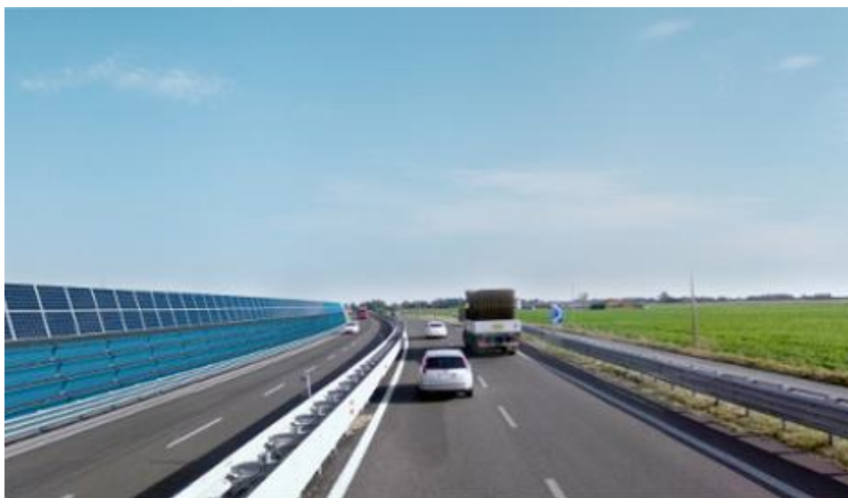
Figura 2.10 – PVNBs da FAR Systems instalados ao longo de uma via
