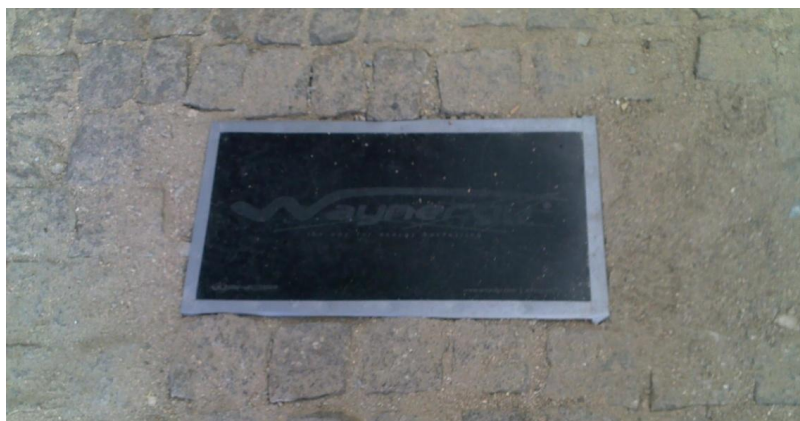
Figura 2.18 – Waynergy People da Waydip instalado na entrada da Faculdade de Engenharia da Universidade da Beira Interior
