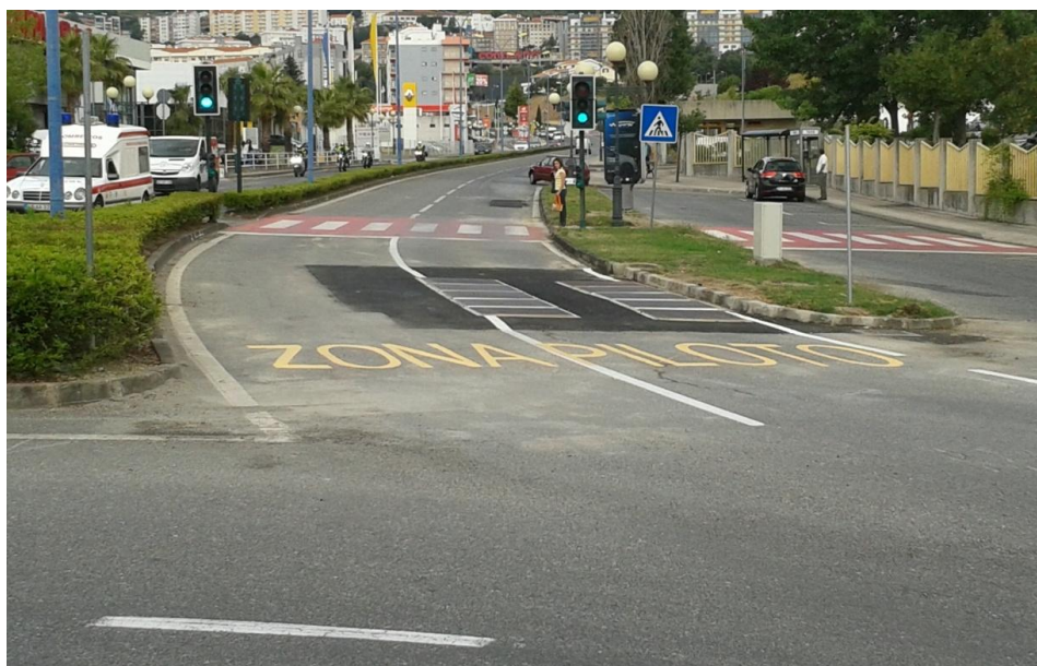
Figura 3.23 – Resultado final depois de fechar a caixa de trabalhos
