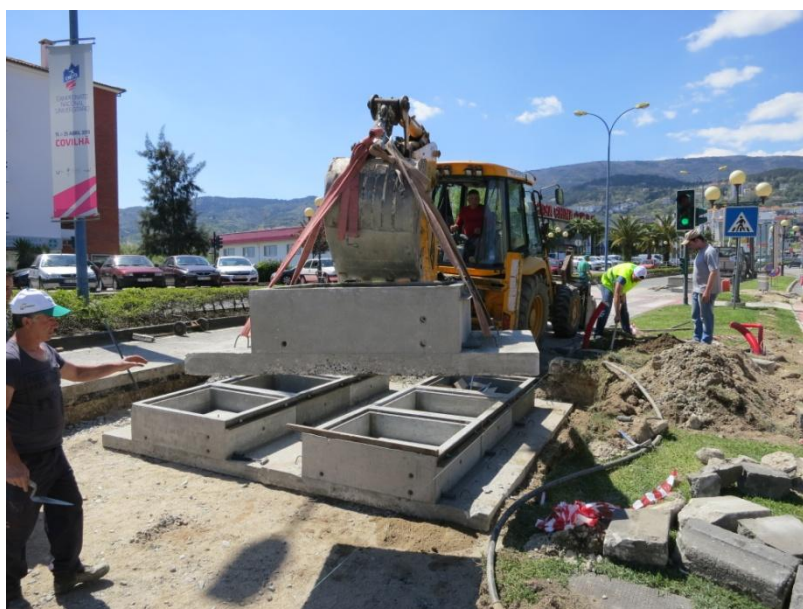
Figura 3.21 – Colocação das peças de betão armado
