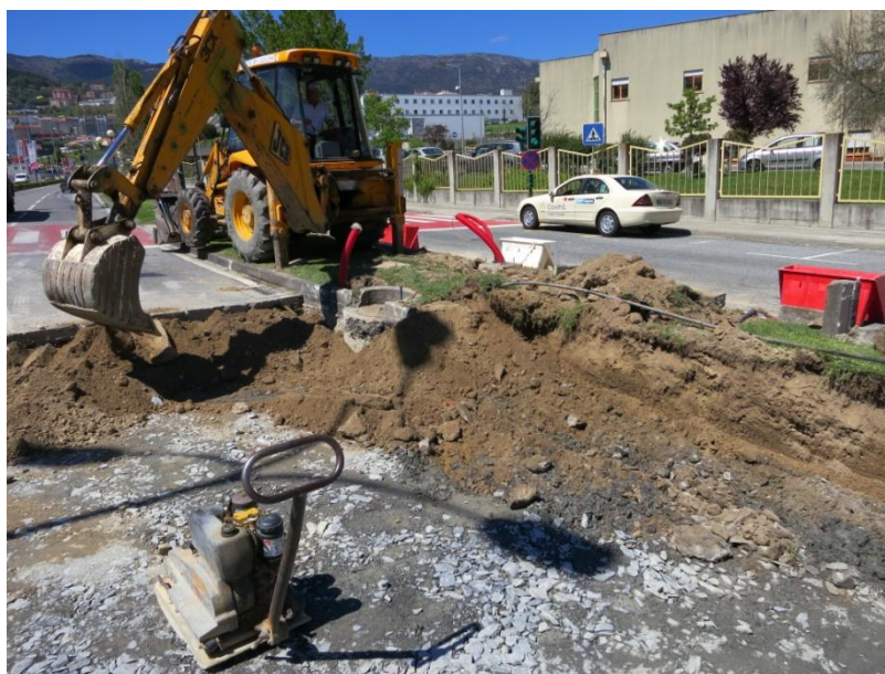
Figura 3.20 – Escavação do separador do lado direito
