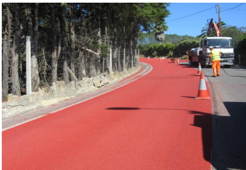
Figura 3.11 – Aplicação do revestimento antiderrapante colorido num pavimento betuminoso
