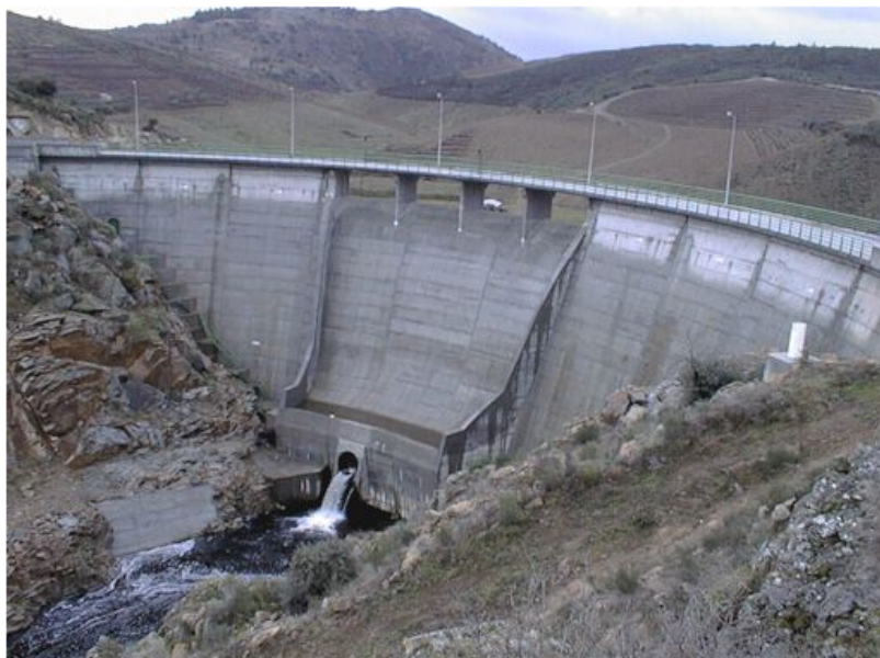
Figura 5.4 – Barragem do Catapereiro antes da construção do circuito hidráulico
