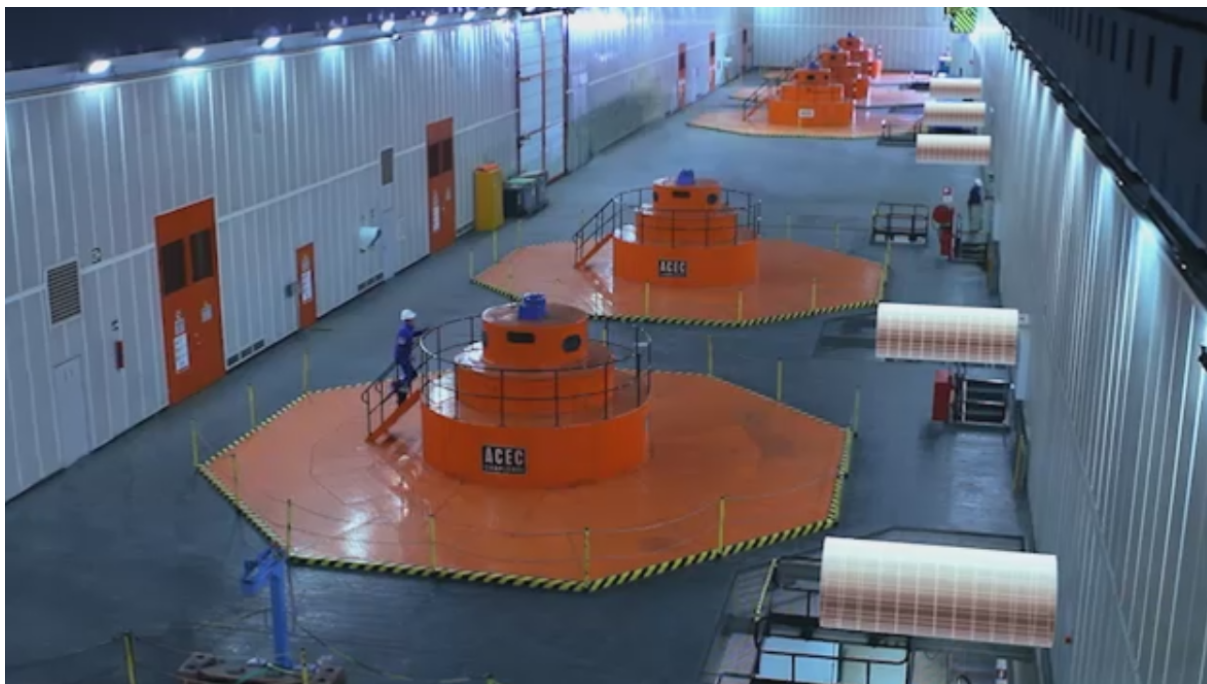
Figura 2.11 – Turbinas Francis na central de Coo-Trois-Ponts
