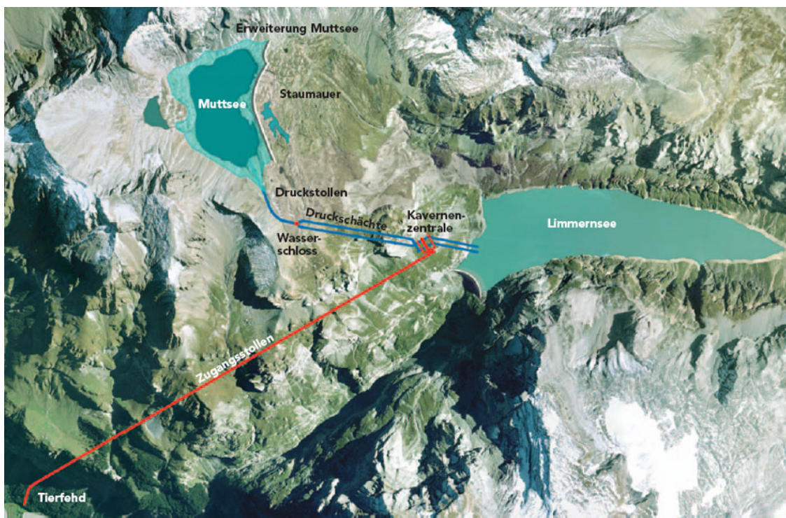
Figura 2.4 - Reservatórios da central (Axpó, 2014)
