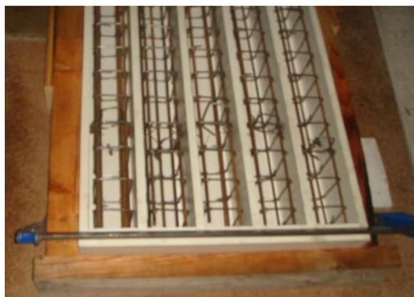
Figura 3.1 – Cofragem das vigas.
