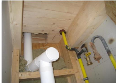
Figura 4.21 – Corte de pavimentos para passagem de tubagens e mudanças de direção brucas (COST, 2014)
