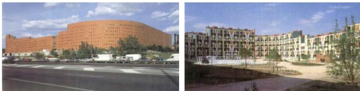
a) Fachada exterior orientada para a fonte de ruído
