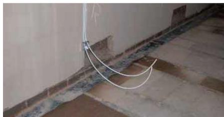
Figura 5.7 - Retirada de blocos para permitir a limpeza de detritos e restos de argamassa na caixa-de-ar das alvenarias de pano duplo (Details, 2004)
