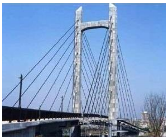
Figura 3.1 - Ponte Shin-Kiba Ohashi ( Okamura et al., 2003)
