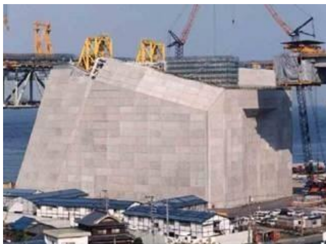
Figura 3.2 - Ancoragem da Ponte Akashi-Kaikyo ( Okamura et al, 2003)
