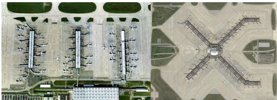
Figura 2.4 - Terminais midfield linear (aeroporto Stansted, Londres) e em X (Aeroporto Internacional Pittsburgh).
