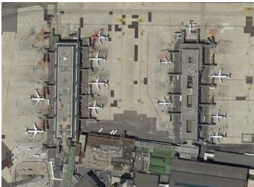
Figura 2.2 - Terminal tipo finger pier (Aeroporto Leonardo Da Vince, Roma).
