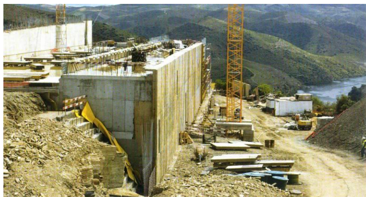
Fotografia 3 – Edifício em fase de construção. Fonte: Revista Património Estudos nº11
