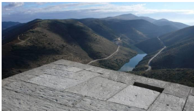
Fotografia 5 – Parte superior do edifício e paisagem. Fonte: http://www.archdaily.com
