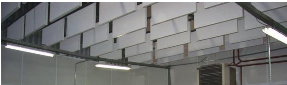
Figura 2.5- Baffles acústicos suspensos (AKUSTIKE@, 2014)
