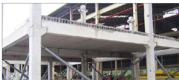
Figura 2.3 – Vigas de secção rectangular indentadas (SCIB, 2013).
