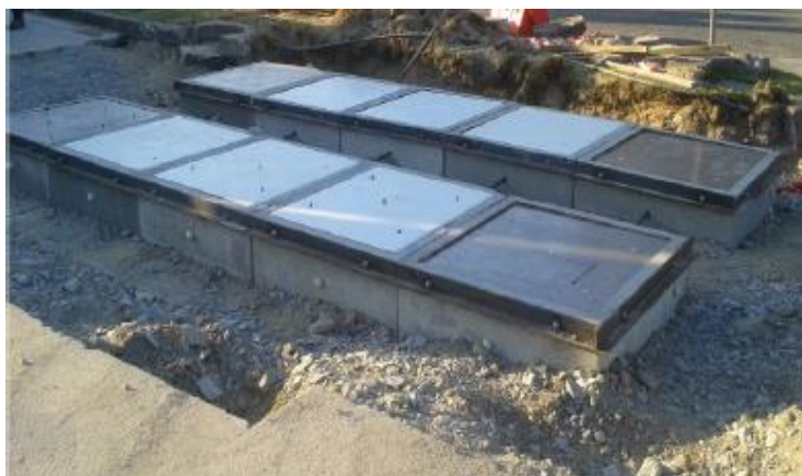
Figura 4.6 – Colocação das peças de betão armado no interior do pavimento.
