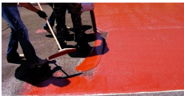
Figura 3.3 – Aplicação manual a frio de um revestimento antiderrapante (Neoasfalto, 2014).
