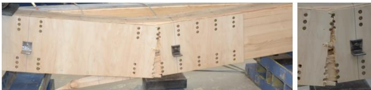
Figura 4.17 - Rutura da Viga 11
