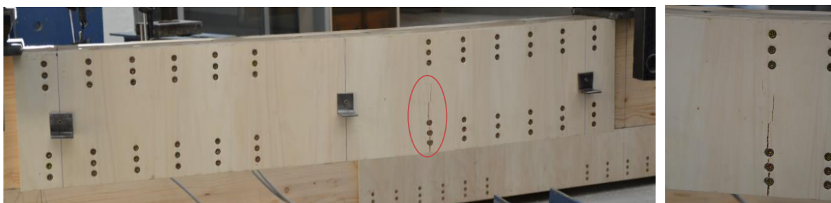
Figura 4.15 - Rutura por bloco dos parafusos da Viga 5
