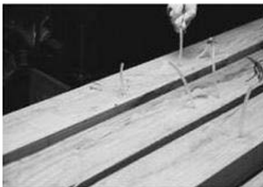
Figura 2.16 - Injeção de resina epoxídica nas fissuras do elemento de madeira (Dias A., 2009)
