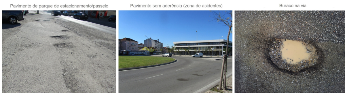
Figura 5.4 – Ocorrências com maior prioridade de intervenção (método “TOPSIS”, categoria “Pavimentos”, segundo conjunto de pesos).
