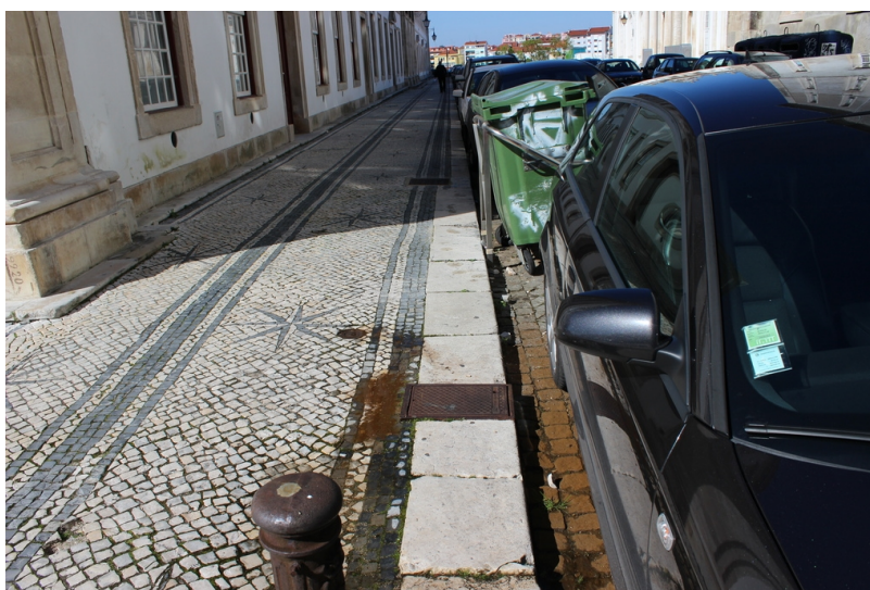
Figura 4.3 – Fuga de água na cidade de Coimbra.
