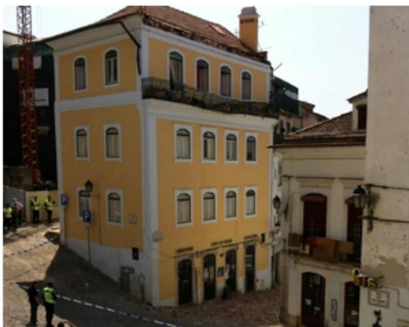
Figura 1.1 – Queda de parte de telhado na Sé Velha, Coimbra (Diário as Beiras@, 2014).
