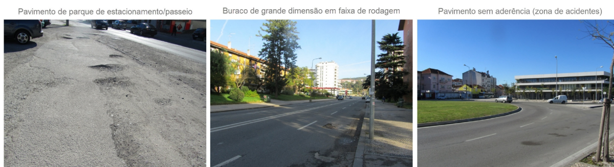
Figura 5.1 – Ocorrências com maior prioridade de intervenção (método “Soma Pesada”, categoria “Pavimentos”, primeiro conjunto de pesos).
