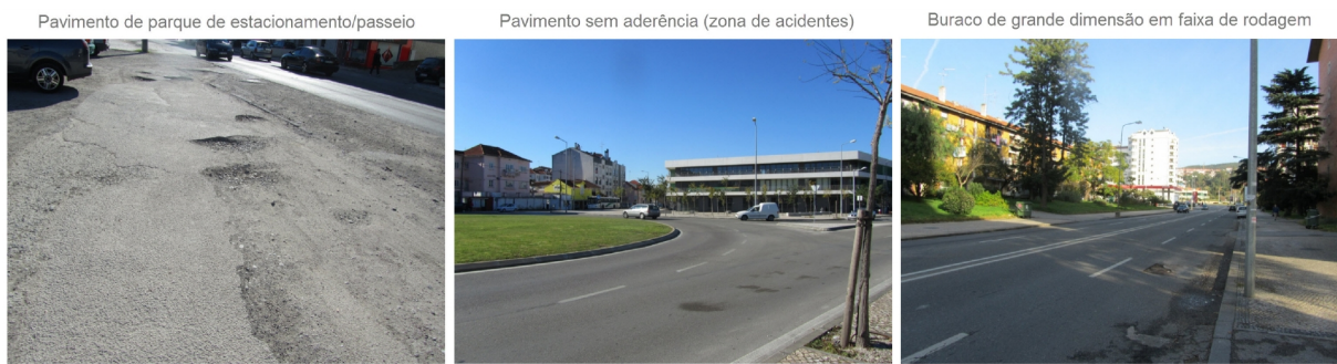
Figura 5.2 – Ocorrências com maior prioridade de intervenção (método “Soma Pesada”, categoria “Pavimentos”, segundo conjunto de pesos).
