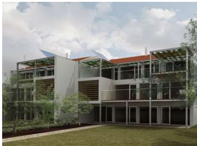
Figura 2.3 – Vista exterior do empreendimento Passive Houses , em Ílhavo.
