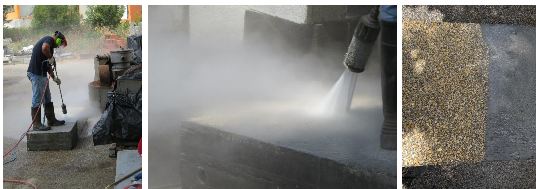
Figura 3.37 - Hidrodecapagem. Aspecto geral, pormenor e comparação de superfície tratada e não tratada
