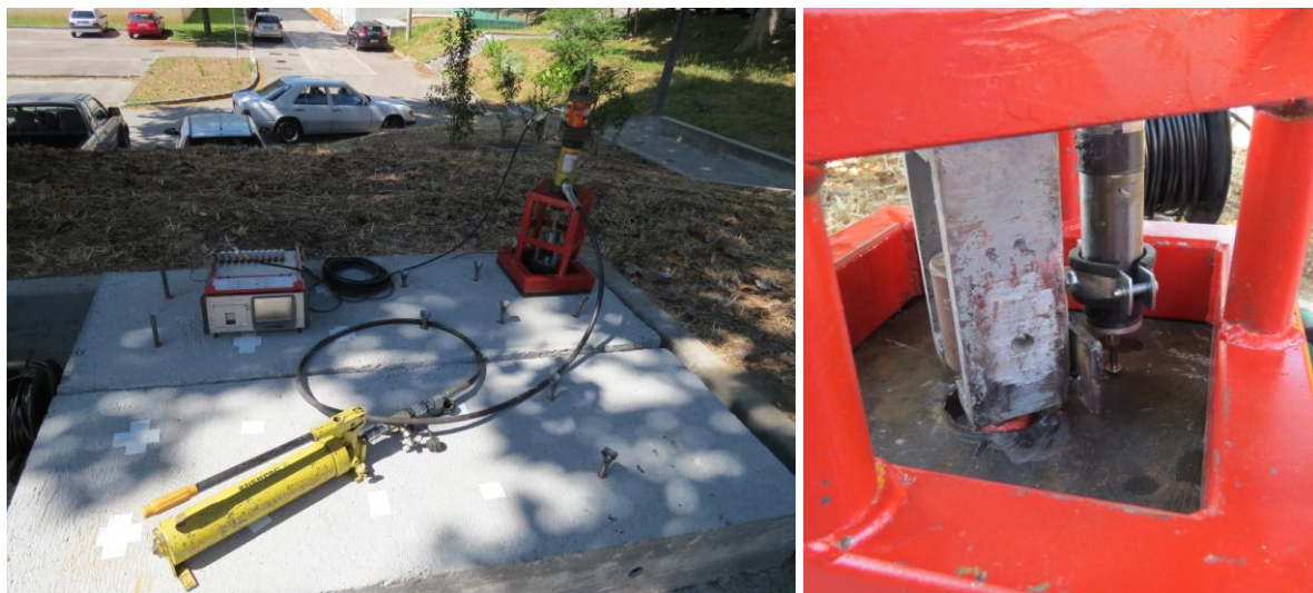
Figura 3.28 - Setup de ensaio de arrancamento no betão e pormenor da fixação do transdutor de deslocamentos
