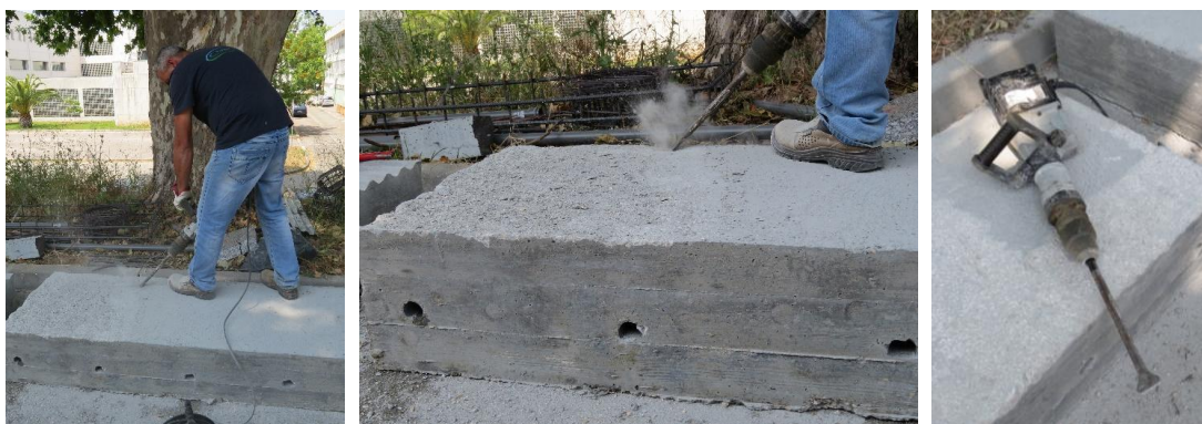
Figura 3.38 – Tratamento de superfície com martelo pneumático
