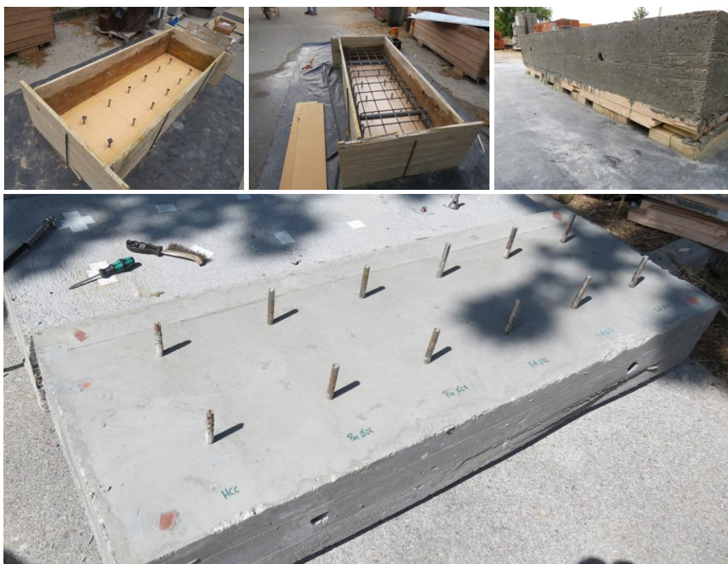
Figura 3.30 - Preparação da laje para a realização dos ensaios de arrancamento do lado da cabeça
