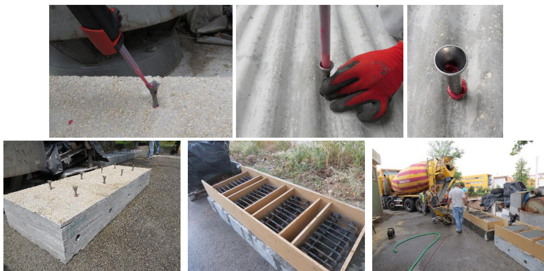
Figura 3.39 - Aplicação dos conectores, preparação e betonagem dos blocos de betão
