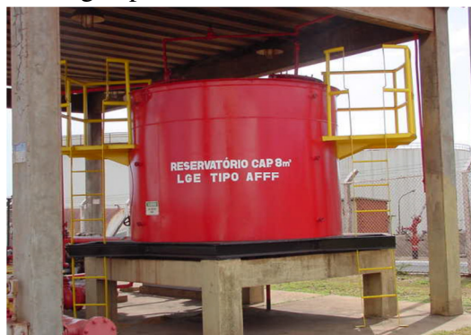
Figura 21. Sistema de injeção de espuma (Fonte: Petrobras Transpetro S.A)
