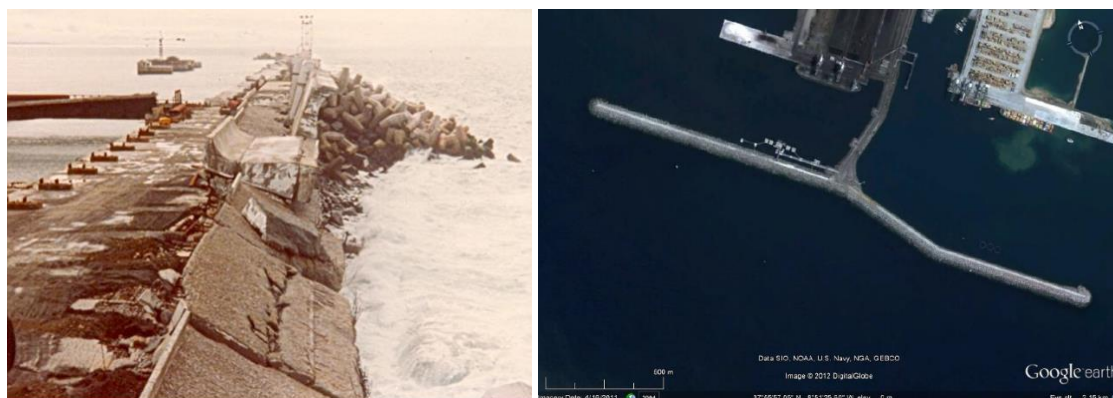
Figura 2.5 - Quebra-mar Oeste do porto de Sines: a) acidente em 1979 (Teresa Reis, et al., 2011); b) imagem Google de 2011.
