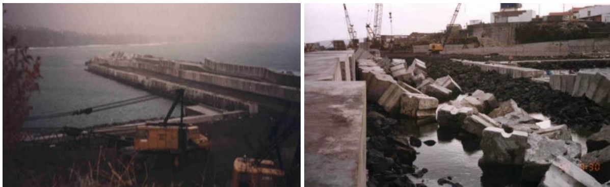
Figura 2.7 – Porto de pesca de Rabo de peixe: a) antes do temporal de Outubro de 1999 (Teixeira, et al., 2001); b) em Outubro de 1999 (Teixeira, et al., 2001).
