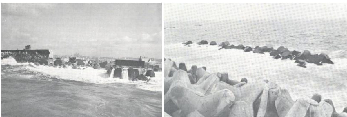
Figura 2.6 – Quebra-mar norte do Porto de Leixões: a) estragos na cabeça do quebra-mar, anos 70 (Ferreira, 2008); b) quebra-mar submerso, 1982 (Ferreira, 2008).
