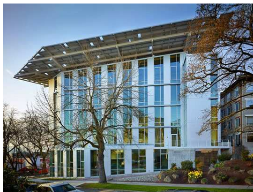
Figura 1.4 – Bullitt Center, Seattle, EUA, edifício comercial mais ambiental do mundo (Engenhariacivil@ 2014).
