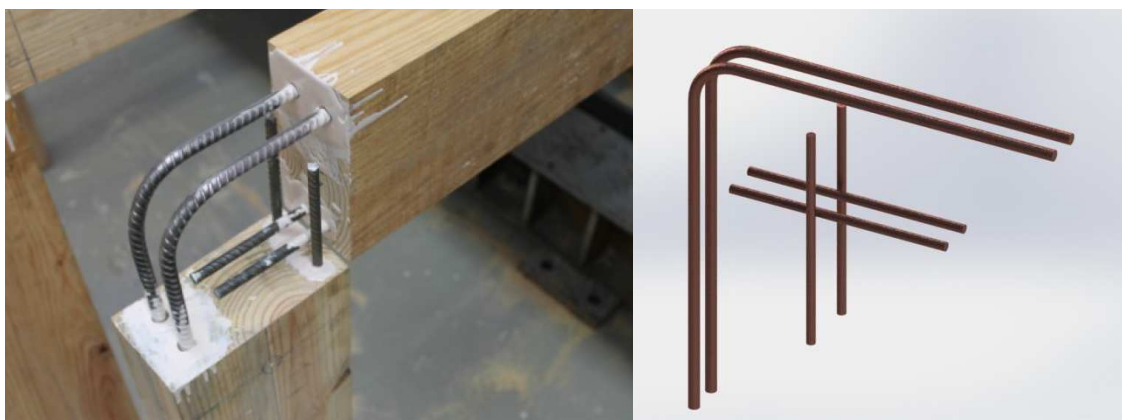
Figura 3.6 – Pormenor das armaduras.
