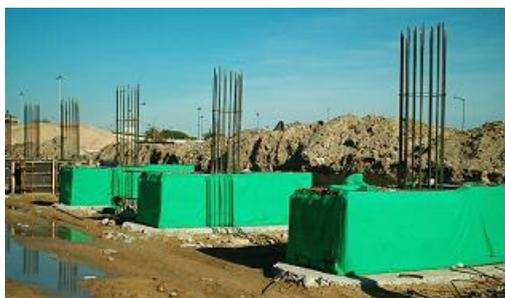
Figura 3.16 – Impermeabilização de um maciço de encabeçamento (Mendes, 2011)
