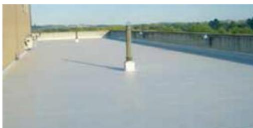
Figura 3.37 – Cobertura plana impermeabilizada com membrana líquida (Sika@ 2013)
