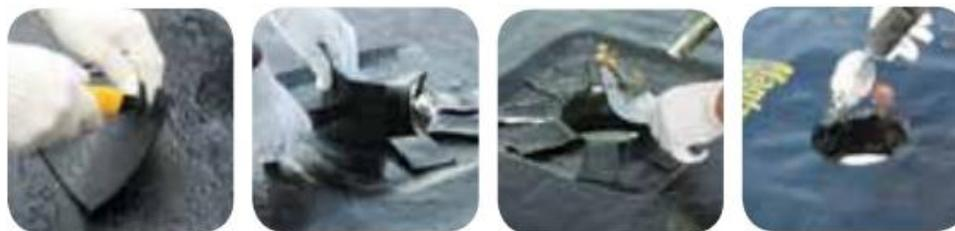
Figura 3.29 - Remate de impermeabilização de um tubo de queda interior com membranas de betume polímero (Vedacit@ 2013)
