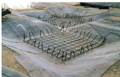
Figura 3.9 – Impermeabilização de uma sapata com membrana bentonítica (H Pedro Martins@ 2014)
