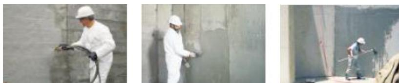
Figura 3.43 – Aplicação de argamassas aditivadas em reservatórios e piscinas (Vandex@ 2013)
