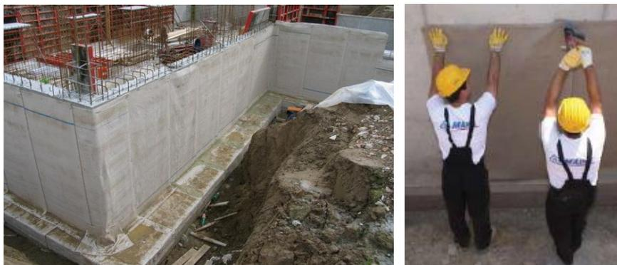
Figura 3.19 – Fixação mecânica de manta bentonítica em suporte vertical (Archiproducts@ 2014) (Mapei@ 2014)
