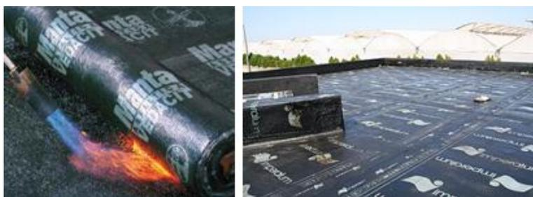
Figura 3.28 - Soldadura de uma membrana de betume polímero (Vedacit@ 2013)
