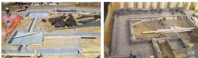
Figura 3.11 – Impermeabilização de toda a fundação antes da betonagem (Elephantnz@ 2014)
