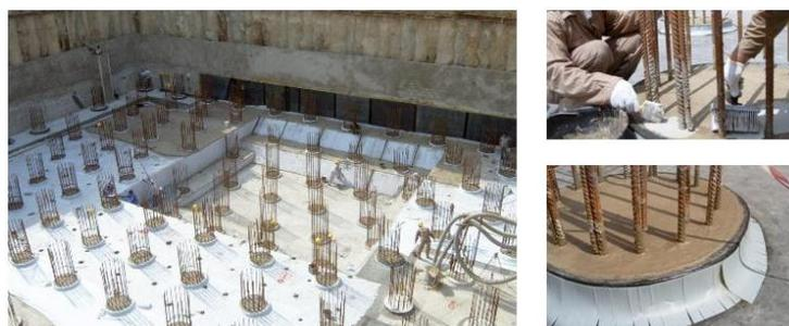
Figura 3.13 – Impermeabilização de estacas (Koester@ 2014)
