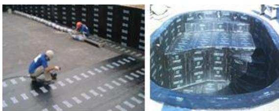
Figura 3.39 – Impermeabilização de piscinas com membranas de betume polímero (Clique Arquitetura@ 2014) (Conceito Impermeabilização@ 2014)
