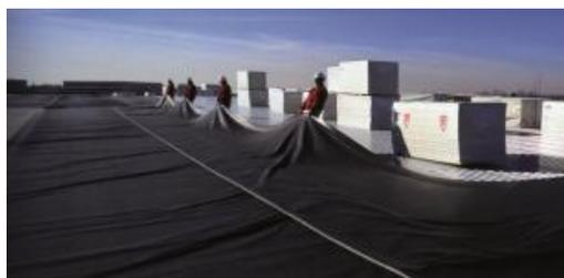
Figura 3.32 - Colocação de uma membrana de EPDM (Firestone@ 2013)
