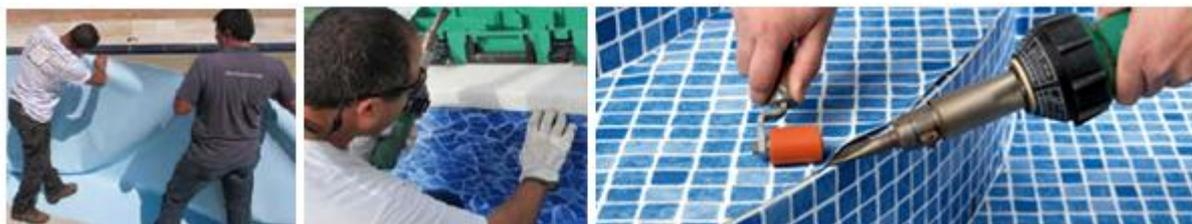
Figura 4.41 – Aplicação de membranas de PVC-P em piscinas (Renolit@ 2013)
