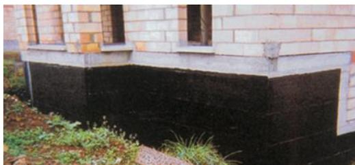
Figura 3.20 – Impermeabilização de paredes enterradas com emulsão betuminosa (Weber@ 2013)
