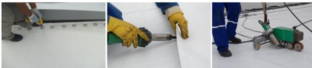
Figura 3.31 - Fixação mecânica pontual e termofusão manual ou mecânica de membranas sintéticas de impermeabilização (Nex Serviços@ 2013) (Techne@ 2013)
