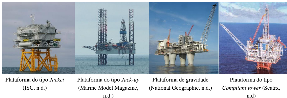
Figura 1.2 – Diferentes tipos de plataformas suportadas no fundo do mar
